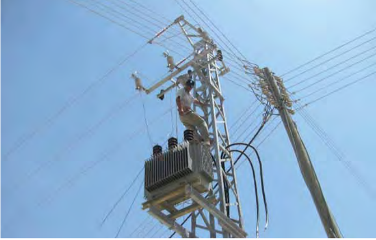
عامل يقوم بصيانة إحدى شبكات الكهرباء في جنوب الخليل.
