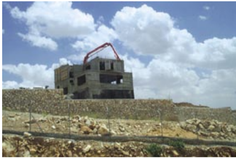
أعمال بناء في إحدى المستوطنات في بيت لحم - عدسة: (الحال).
