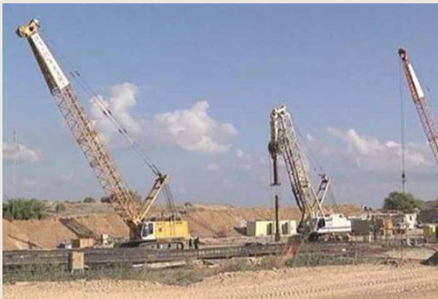
أعمال بناء الجدار
