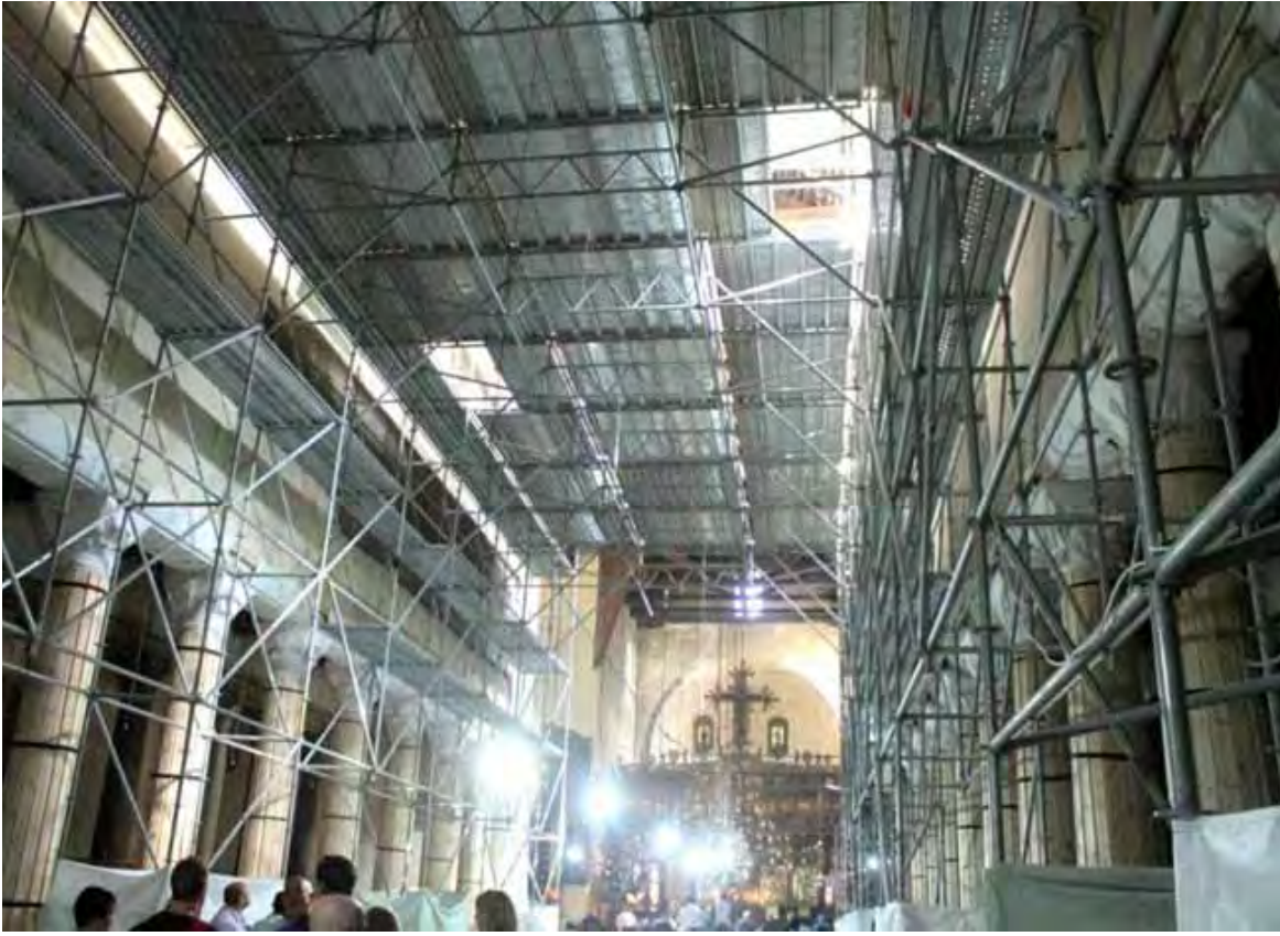
بدء أعمال الترميم في «المهد».
